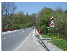
Gefährliche Straßenquerung außerorts
