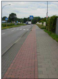
<2m (je Straßenseite <1m), gut befahrbar, entlang befahrener Straße
